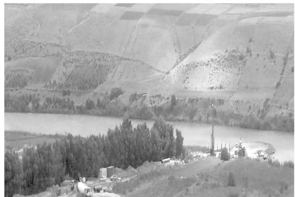
Photo n°2 : Chantier de construction du réservoir d'eau du projet de sauvetage de la région d'Azemmour-Bir Jdid
